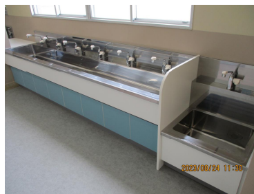
新しくなった手洗い場
